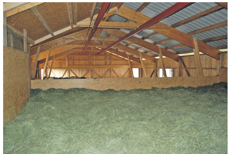
Eine Trocknungsanlage ist richtig dimensioniert, wenn der gesamte erste Schnitt Platz hat.
